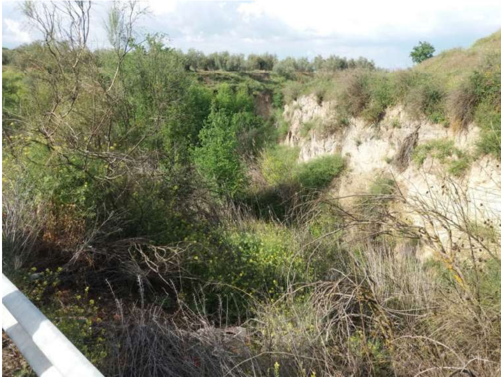
Fotografía 13. Puente 3 aguas abajo
