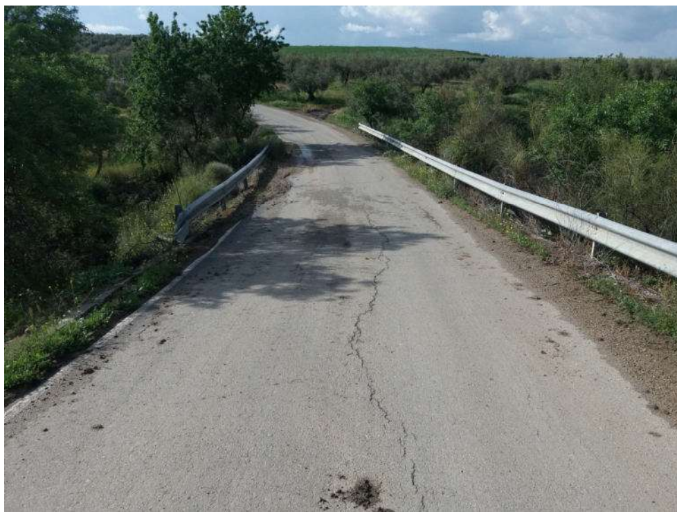
Fotografía 11. Puente 3 desde margen derecha
