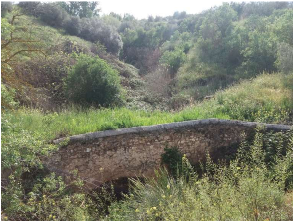
Fotografía 14. Puente 3 aguas arriba
