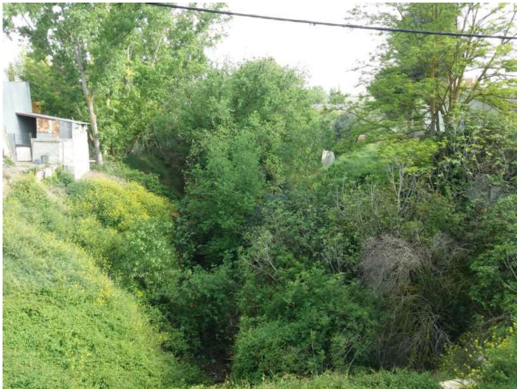
Fotografía 8. Puente 2 aguas arriba
