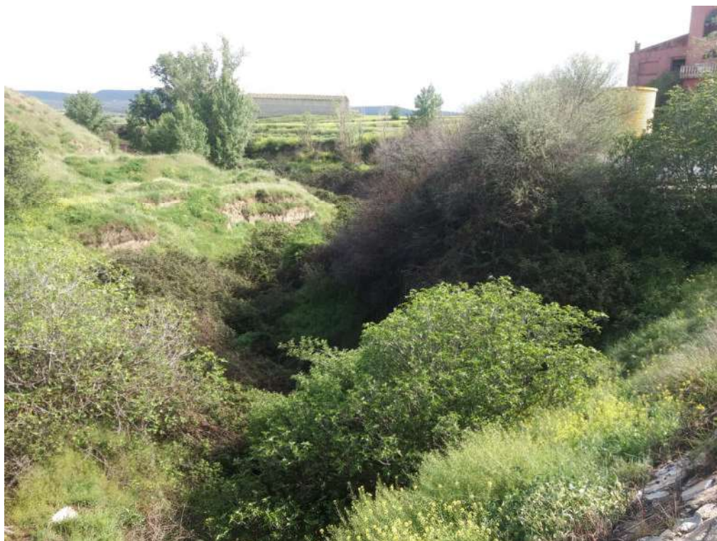
Fotografía 3. Puente 1 aguas arriba
