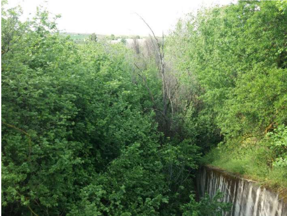
Fotografía 9. Puente 2 aguas abajo
