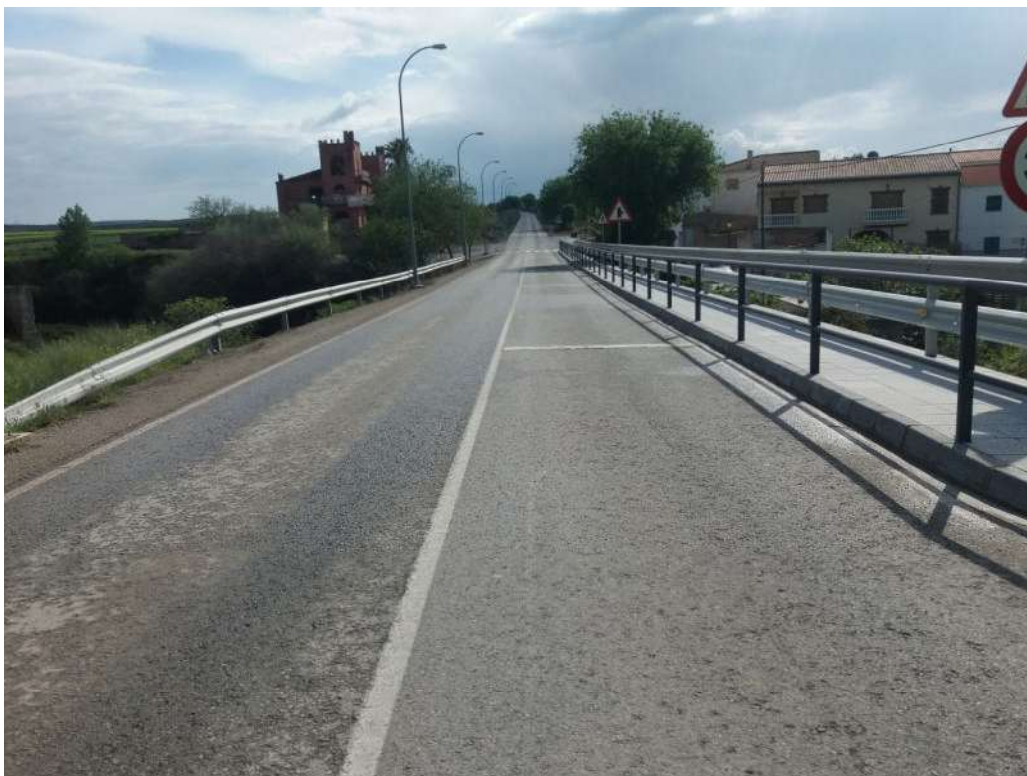
Fotografía 2. Puente 1 desde margen derecha
