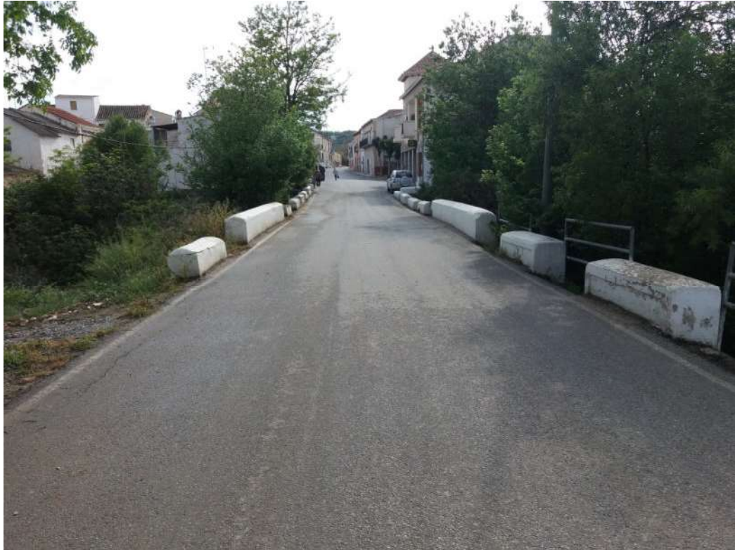
Fotografía 7. Puente 2 desde margen derecha
