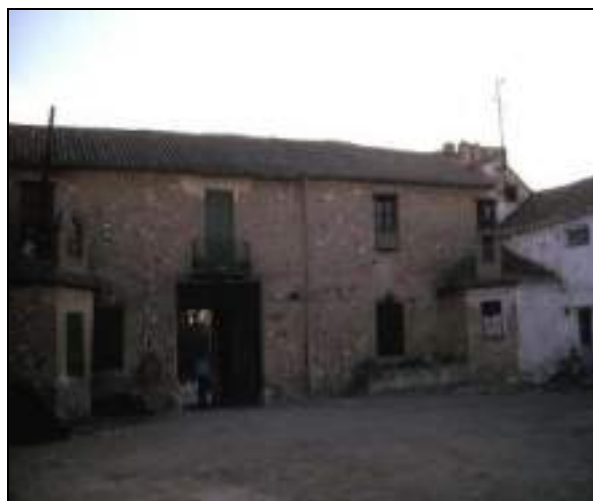
Pilares del cortijo Los Frailes
